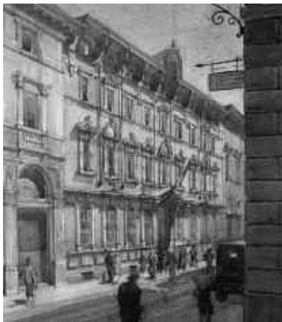
Facciata del Palazzo Corio-Casati di via san Paolo, sede della Banca dal 1872 al 1931.
